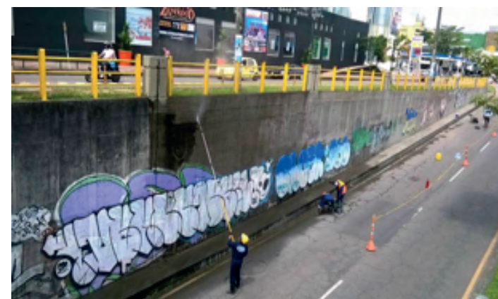
Ilustración 3 Inicio labores de limpieza , mayo 2014.
