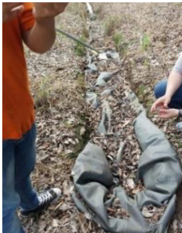
Figura 2. Detalle de la geomembrana y de los elementos de conducción asociados al biodigestor.
