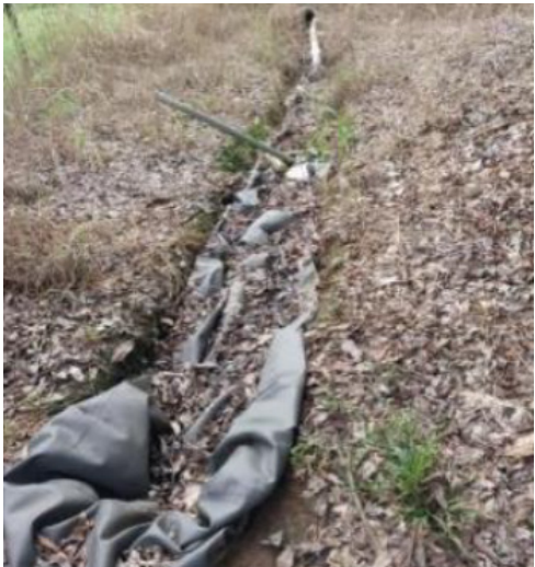
Figura 3. Vista longitudinal del biodigestor de membrana y condiciones generales del entorno inmediato.
