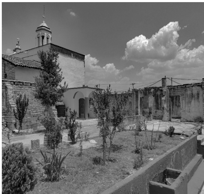
Figura 3. Albercas y espacios del antiguo balneario de San Pedro de los Baños.
